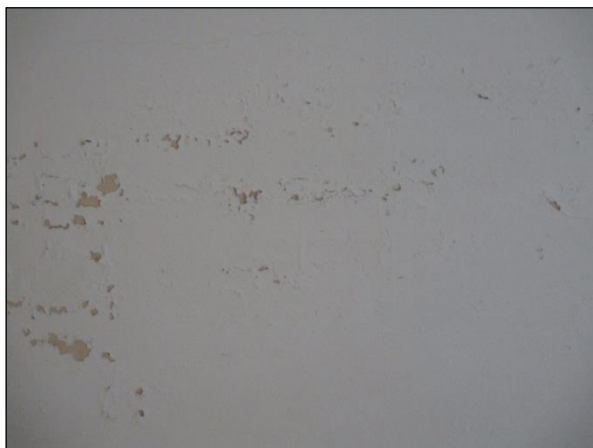
Foto n°24 - Porzione dell'intradosso del solaio presente nel Locale Bidelli al piano terra in pessimo stato di conservazione.
