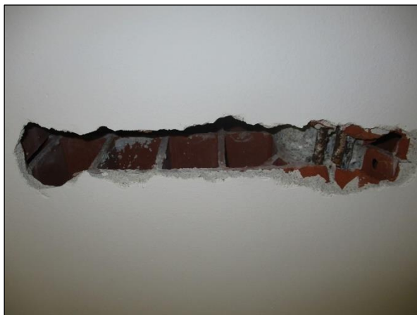
Foto n°15 - Vista generale del saggio eseguito nella Mensa al piano seminterrato.
