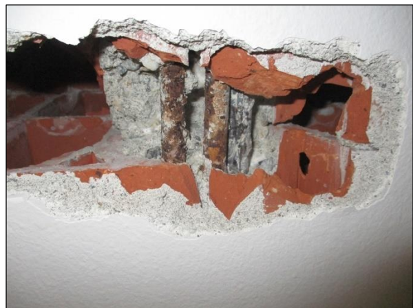
Foto n°16 - Particolare del travetto gettato in opera.
