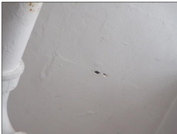
Foto n°26 - Porzione dell'intradosso del solaio presente nel Bagno 2 al piano seminterrato in pessimo stato di conservazione.
