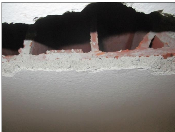
Foto n°17 - Spessore dello strato di finitura applicato al solaio.
