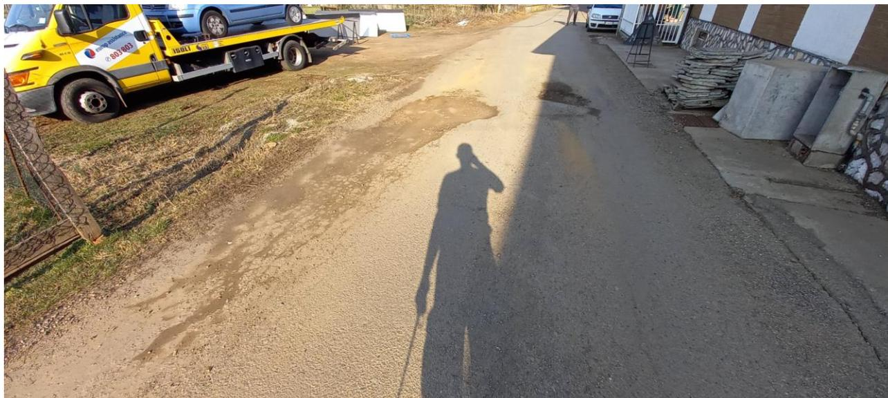
6. Via XX Aprile tra il n. 7/A ed il 42 in Fraz. Tonengo risulta in un avanzato stato di degrado con manto stradale a zone instabile e deteriorato oltre a zone completamente dissestate e prive di fondazione.
